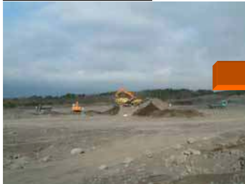
養浜材の採取状況 (富士山大沢扇状地内)
