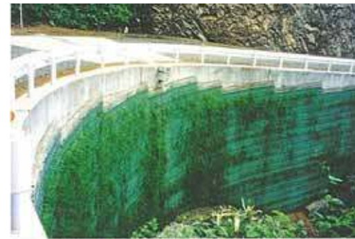
新工法（ワイヤーウォール工法）
