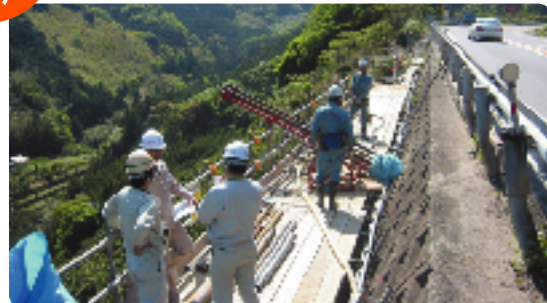
42号河瀬（鹿ヶ瀬）地区擁壁補強工事：近畿地整・和歌山河川国道事務所
