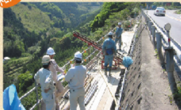
4号河瀬(産ヶ瀬)地区崩落補強工事：近畿地整・和歌山河川国道事務所
