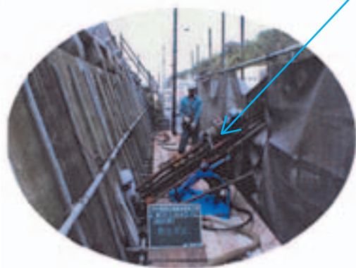
削孔状況（使用機械：インバーターチゼル）
