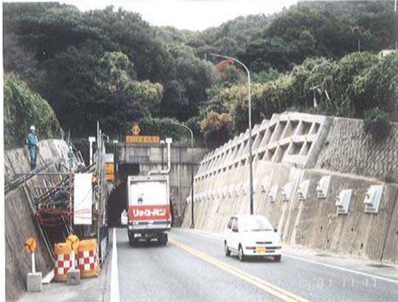
一般国道2号 勝谷防災工事
