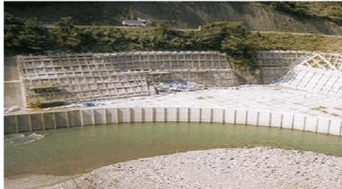
近畿地方整備局大滝ダム工事事務所: 対岸道路八幡平工区工事
