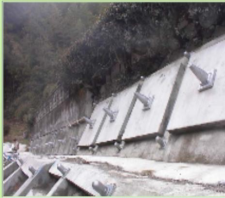
無水掘工法により定着層の位置、及び厚層を確認し(-7.0~8.5 以深)施工した。
