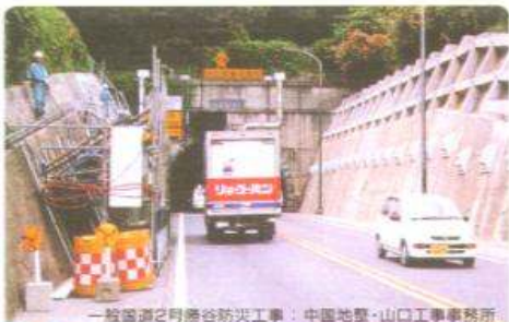
一般国道2号巻谷防災工事：中国地盤・山口工務事務所
