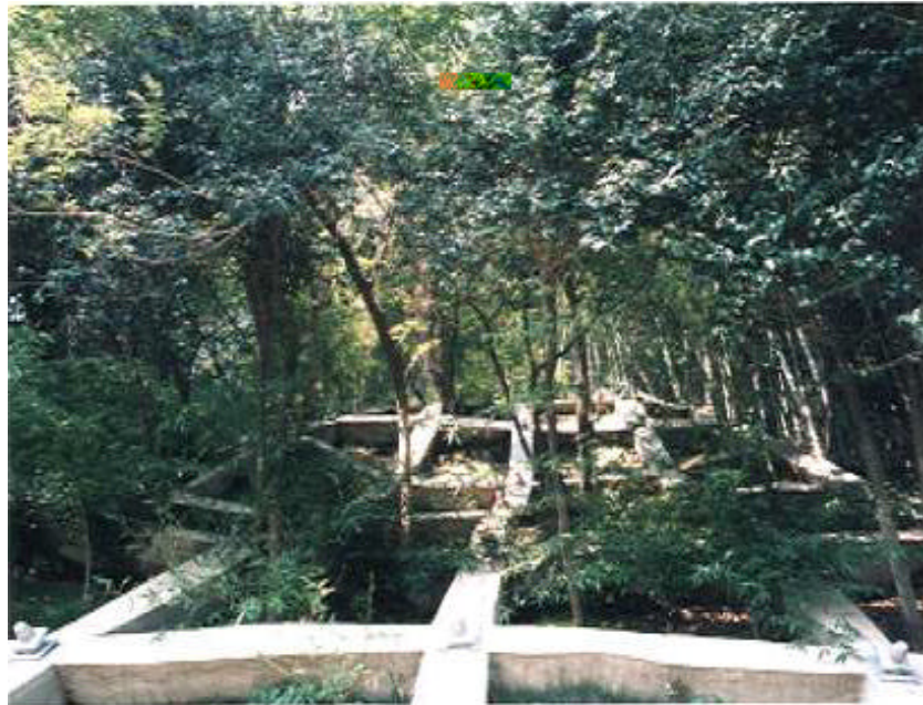
工事完了後3ヶ月
