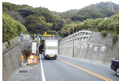
一般国道2号勝谷防災工事 山口河川国道事務所
