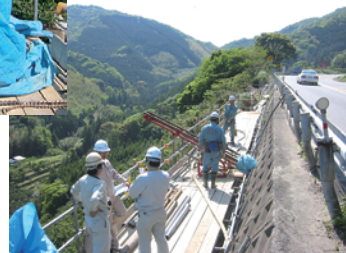
42号河瀬(鹿ヶ瀬)地区擁壁補強工事 和歌山河川国道事務所
