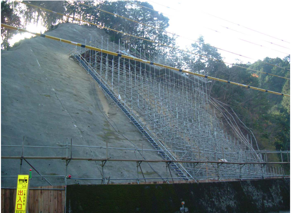
フィールド事業 仮設足場全景(幅4.5m)
