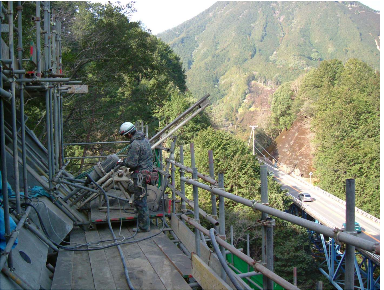
中部地方整備局 紀勢国道事務所 42号海山鷲毛地区法面防災工事
