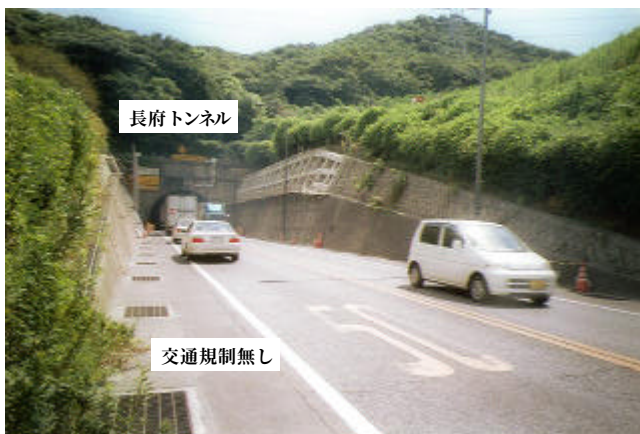
図4. 山口県：R2 勝谷防災工事
