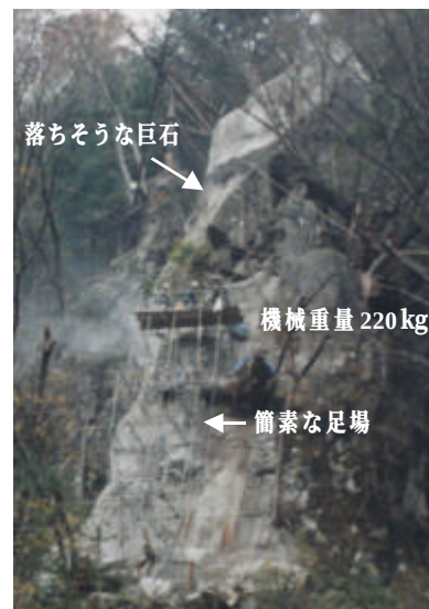
図 6. 岩部拡大施工状況
