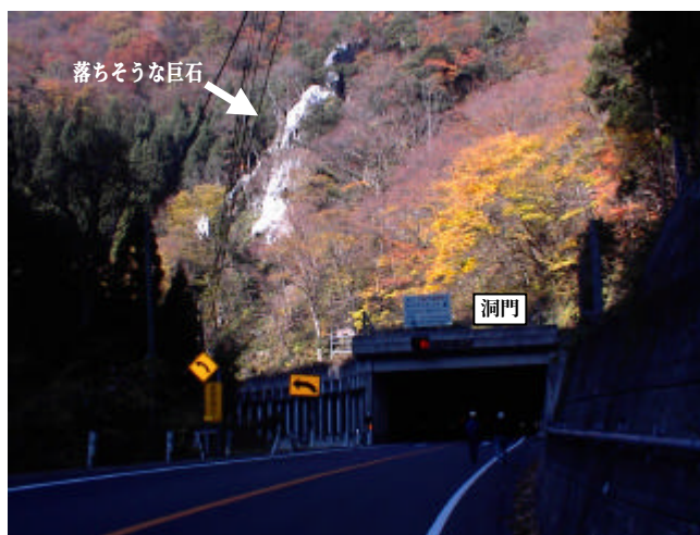
図 5. 鳥取県：国道 29 号落折防災工事
