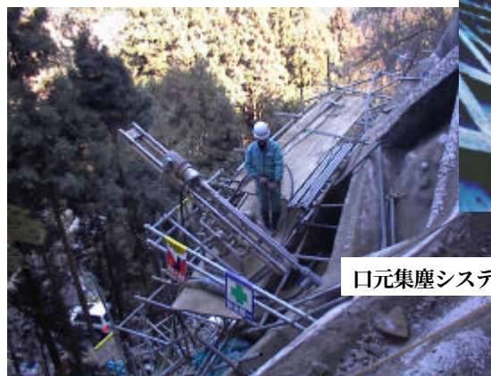
図 8. 大阪府：CMP カンプリート工法削孔状況
