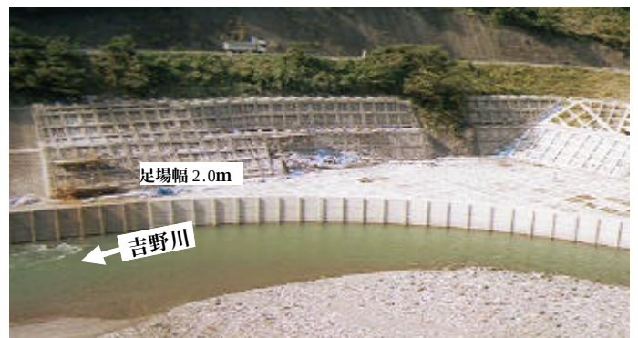
図 2. 奈良県：大滝ダム対岸道路八幡平工区工事
