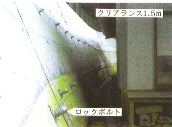
図 C. 奈良県：天川村自然災害防止(沢原急傾斜地)工事
