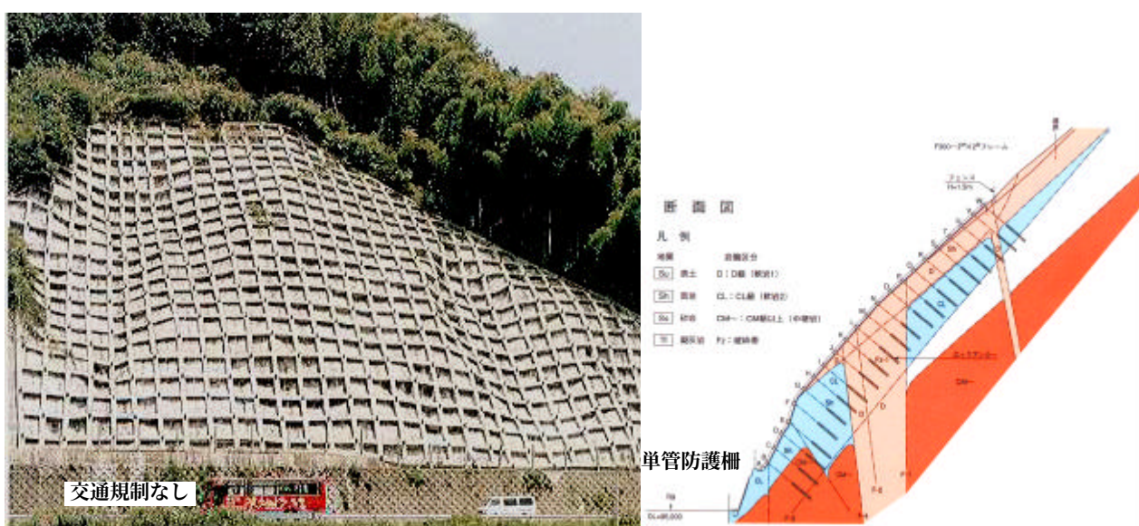
図1. 京都府：R9 夜久野日置地区法面防災（その2）工事完成写真および断面図
