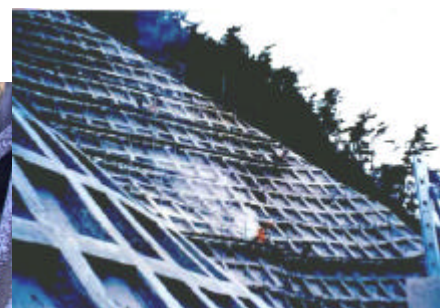
図 7. CMP カンプリート工法開発以前の削孔状況
