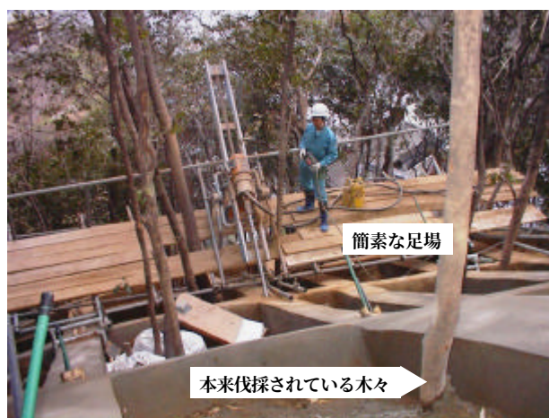
図 11. 大阪府：緑の斜面工法施工状況
