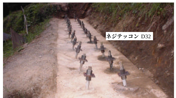
図 3. 奈良県：十津川村奥里地区急傾斜地崩壊防止工事
