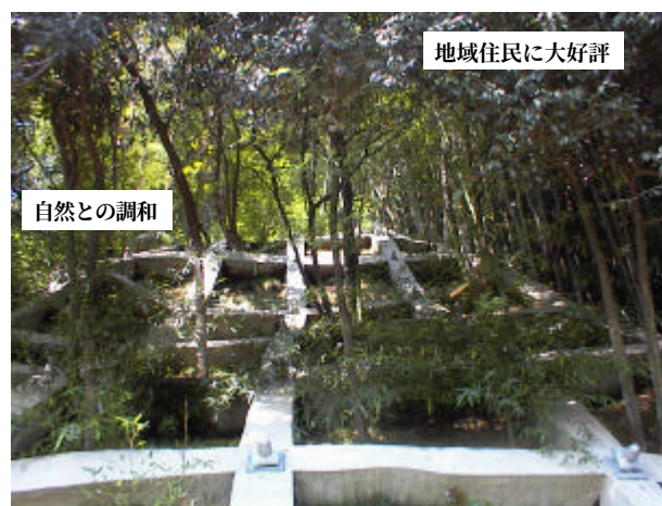
図 12. 緑の斜面工法施工完了 2 ヶ月後
