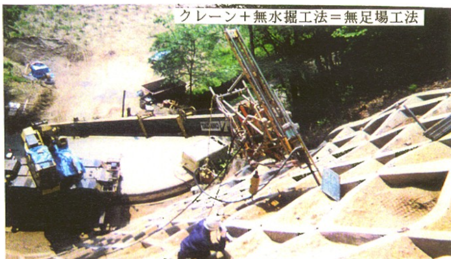
図 D. 京都府：大宮岩滝線道路災害復旧工事
