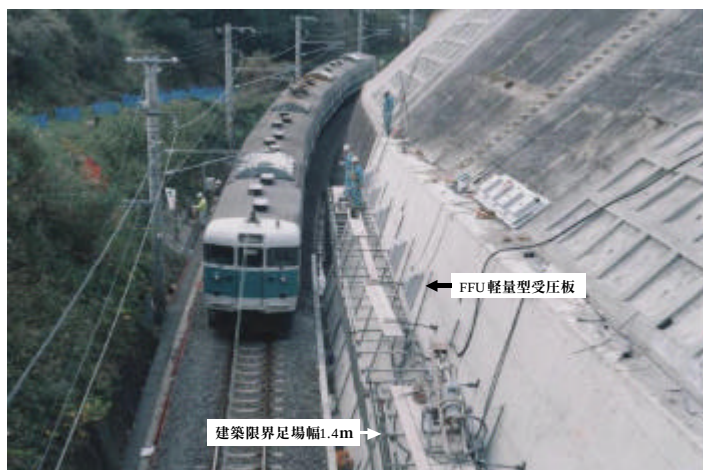
図 13. 和歌山県：FFU 軽量型受圧板工法施工状況
