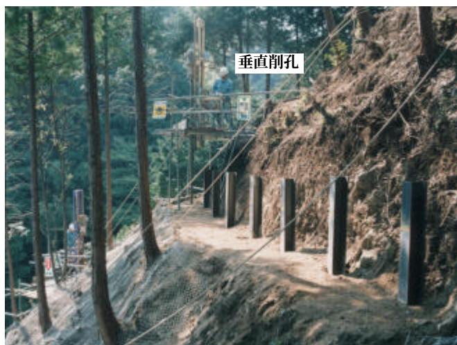
図 9. 大阪府：垂直複数削孔工法施
