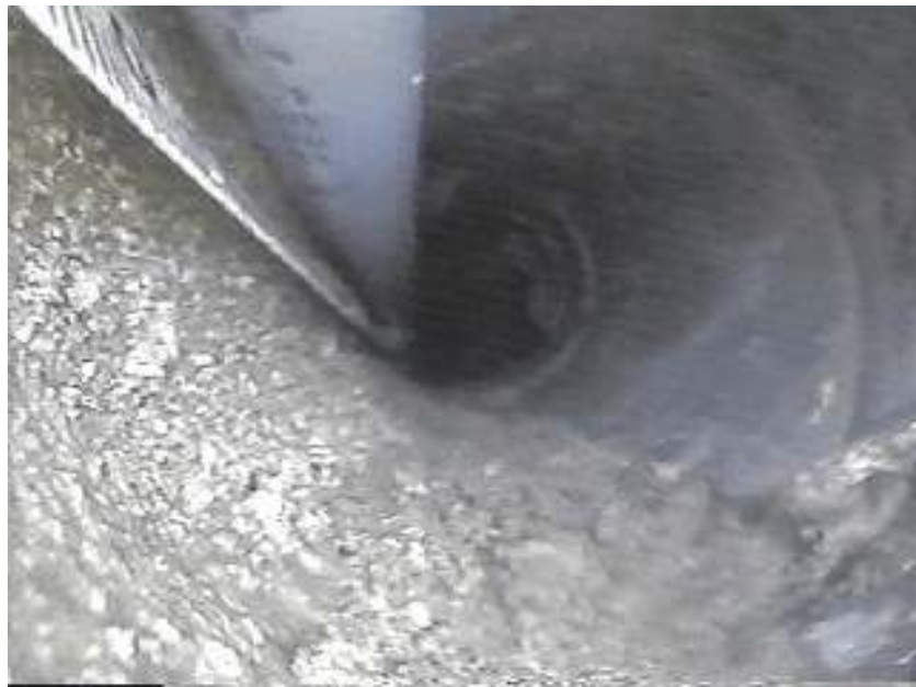
0.2m (法枠コンクリート部)
