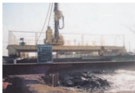
【比較：高圧噴射攪拌工法】
