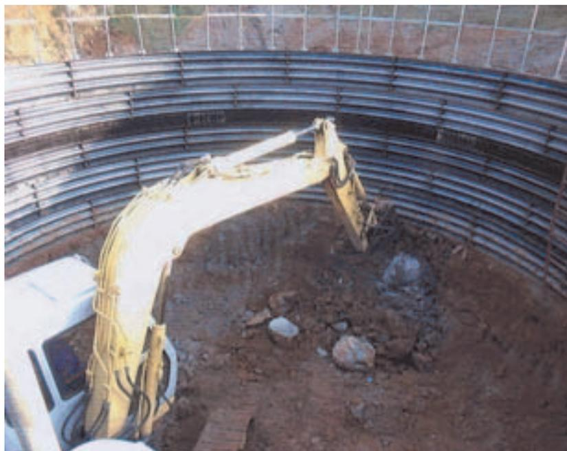
〔深礎掘削：ブレイカー掘削状況〕
